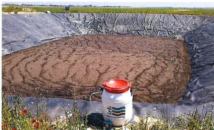
Bassin de stockage
