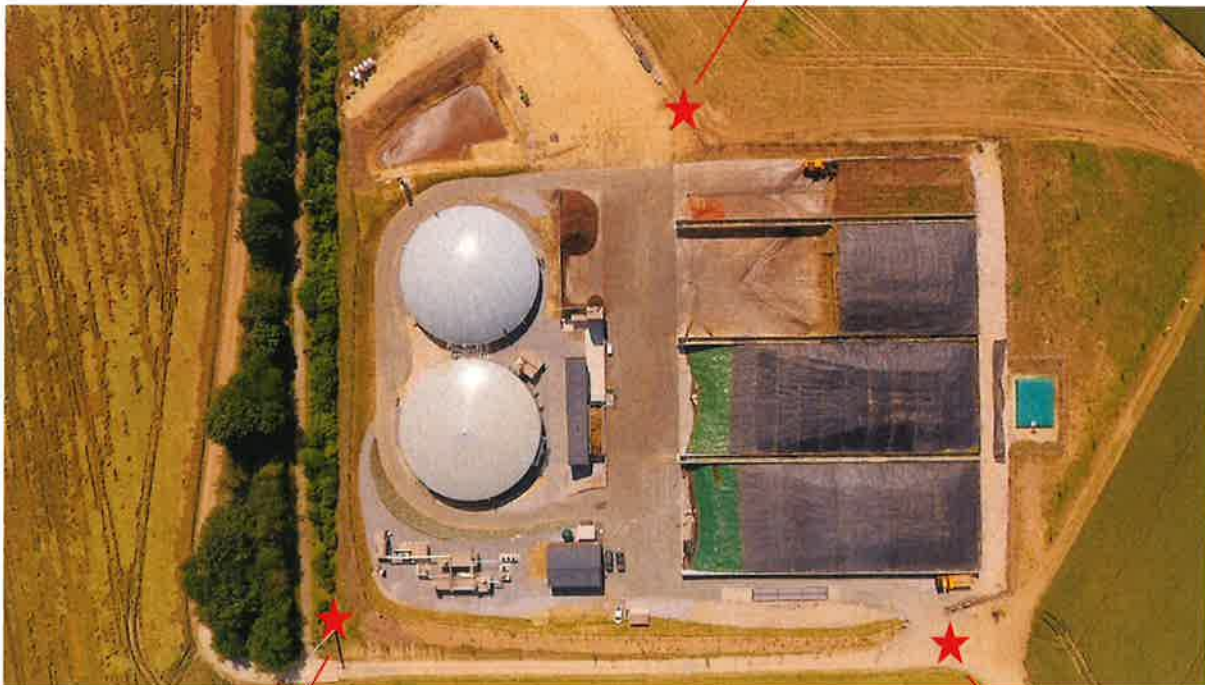
Usine de méthanisation Valois Energie
